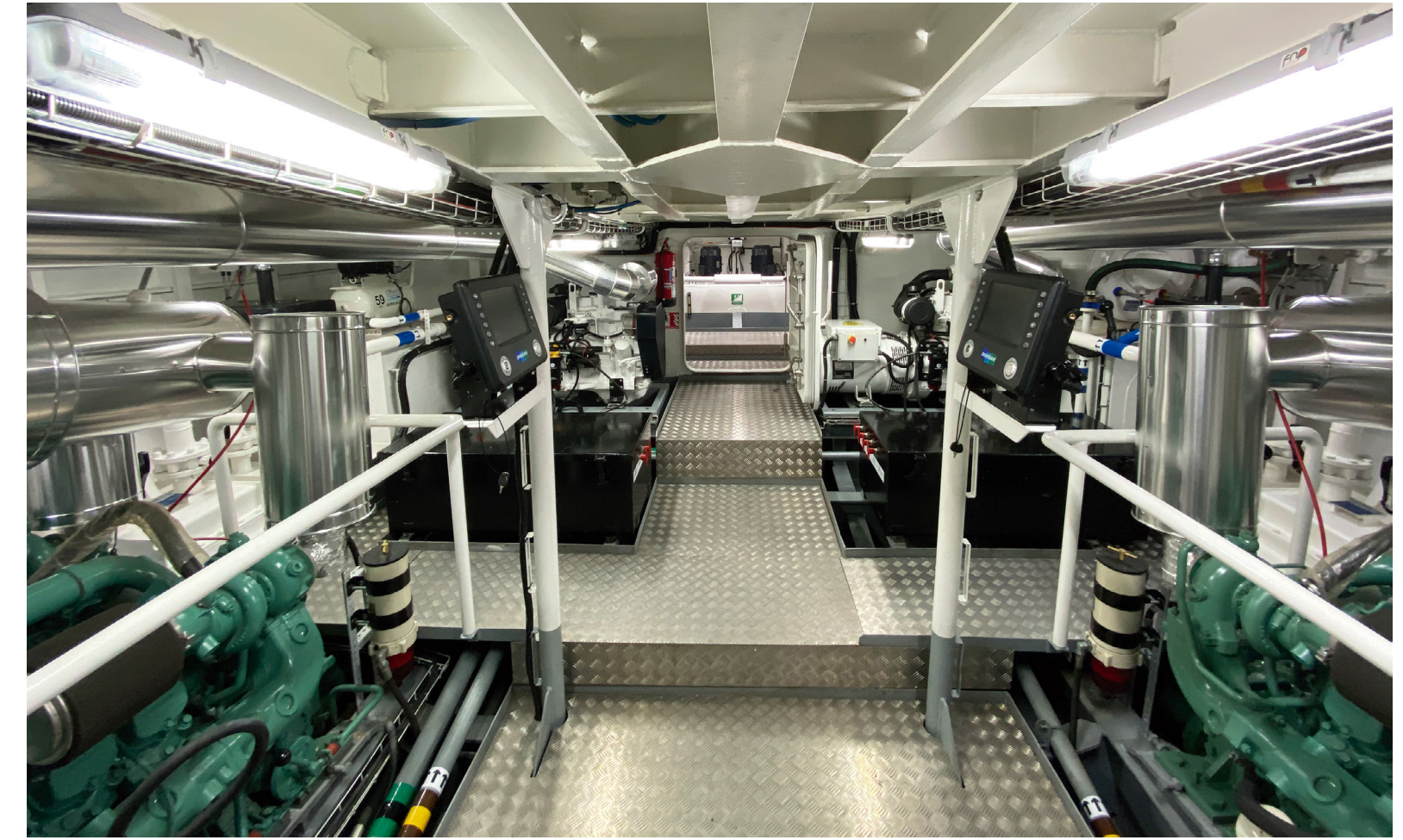
Sala de máquinas
